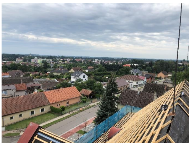
1. 8. 2024 – pohled ze střechy
