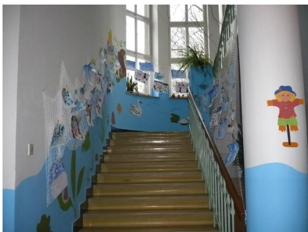
Stav schodiště před rekonstrukcí
