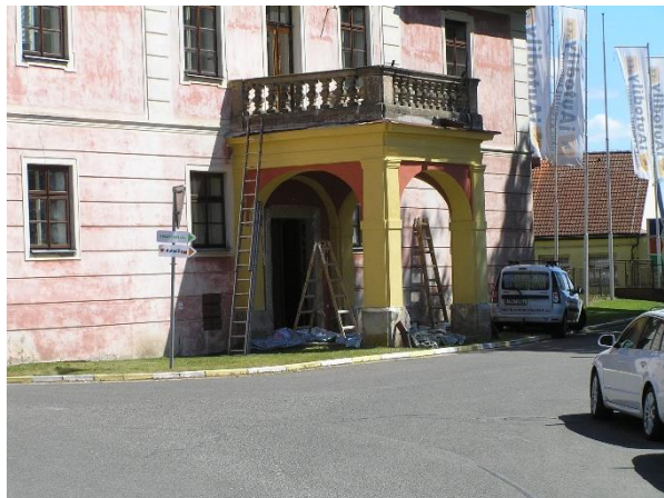
a fara nový kabát vstupního portálu.
