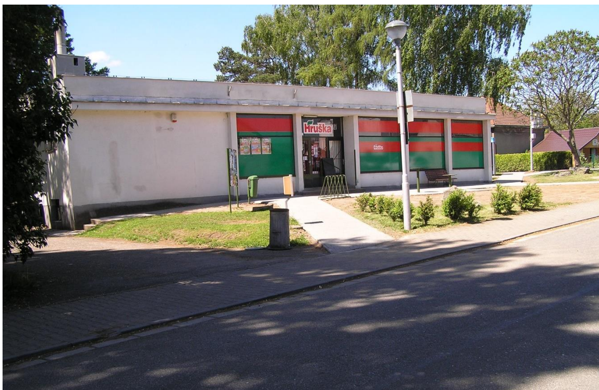
Prodejna Hruška – opravené chodníky
