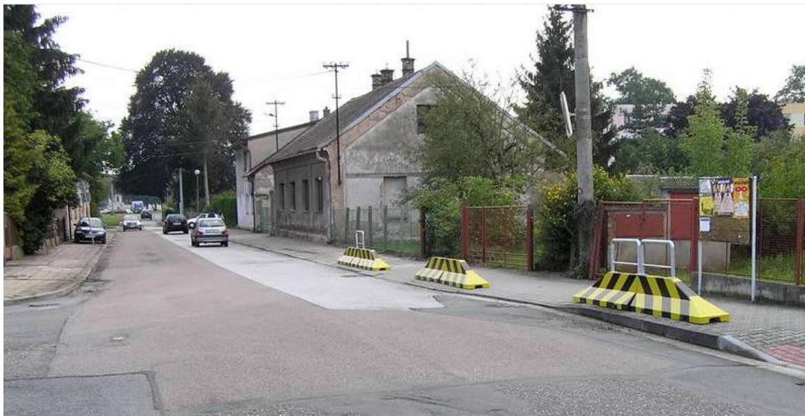
6. 9. 2017 – zábrany pro větší bezpečnost chodců na křižovatce ul. Na Lávkách a Mlýnské
