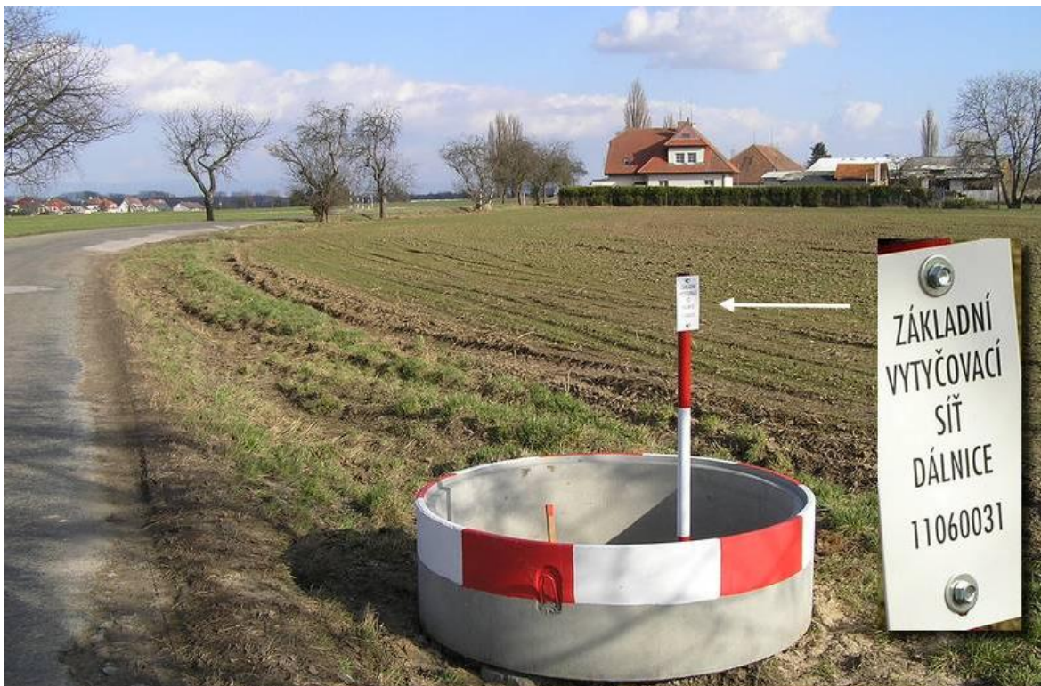
Tak se konečně bude dálnice stavět. Toto místo je asi uprostřed budoucího křížení, vzadu leží školní statek. 15.3.2017
